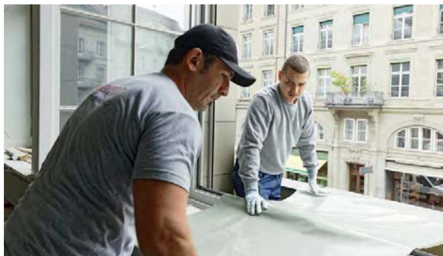
^ Die Berufsleute decken das Fensterbrett ab, über das später der Pumpenschlauch mit dem Fliesboden gezogen wird.
