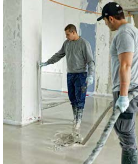
^ Die Bodendicke wird regelmässig gemessen: Ideal sind in diesem Fall 55 Millimeter.
